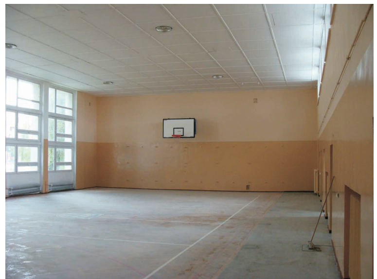
Remontowana sala gimnastyczna - Zespół Szkół Zawodowych nr 1 w Strzelcach Opolskich
