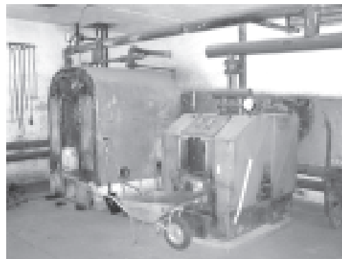
Kompleksowa modernizacja systemu ciepłotego SOSW w Leśnicy
