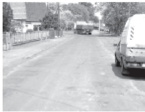
Łąki Koziełskie - modernizacja ciągu komunikacyjnego wsi – drogi nr 1434
