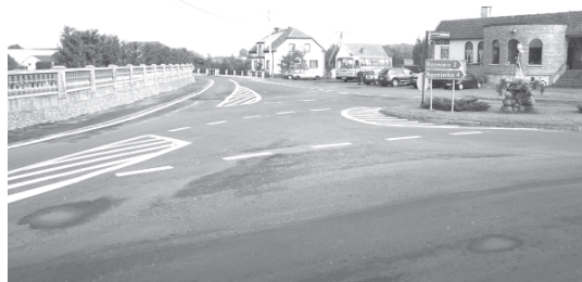
Przebudowa drogi powiatowej w Suche – II etap inwestycji obejmującej remont kapitalny nawierzchni, budowę chodnika i wykonanie ścieku – kosztowała 449.808,17 zł
