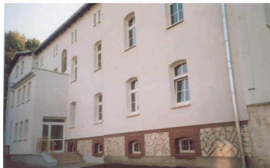
ostatni etap przebudowy budynku głównego filii w Leśnicy dofinansowano ze środków Kontraktu województwa opolskiego 2004.
