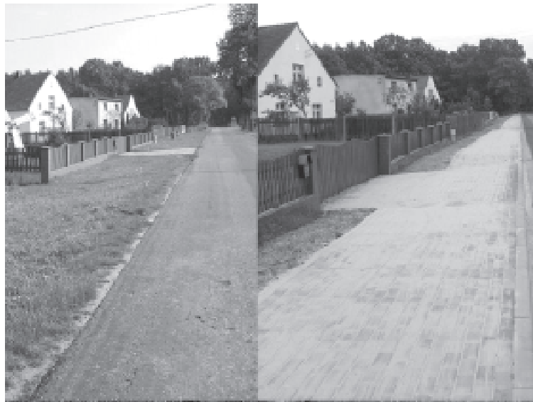
Barut: przed i po remoncie drogi
