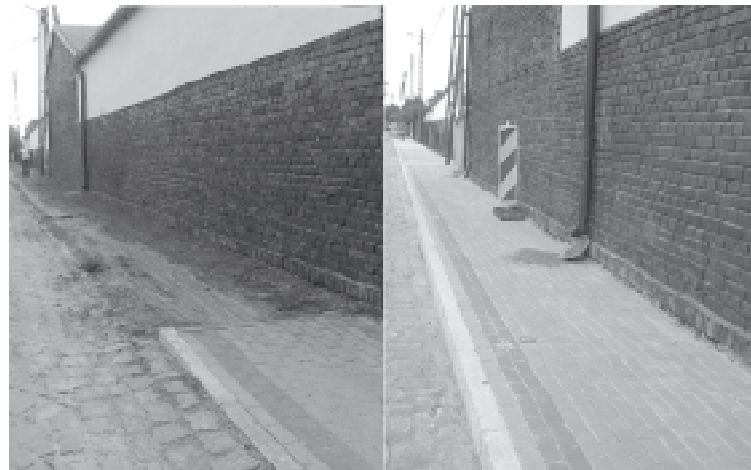
Żędowice: przed i po remoncie drogi
