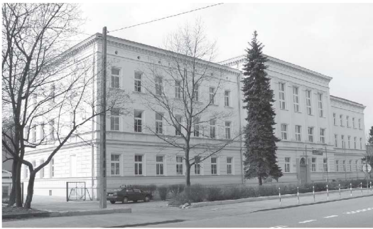
Budynek Zespołu Szkół wybudowany w 1871 roku; wygląd obecny
