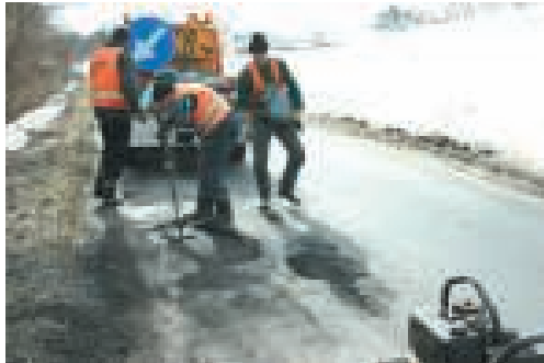
21 marca - prace przy naprawie nawierzchni drogi Olszowa - Zimna Wódka - Stary Ujazd
