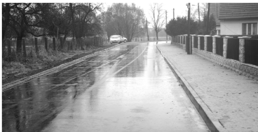
Suchą nogą w deszczu – aura pozwoliła już przetestować odwodnienie drogi.
