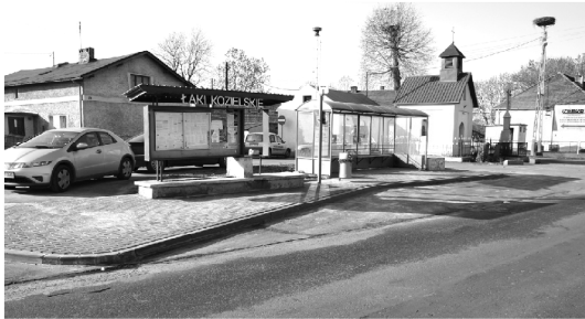
Na pewno jest bezpieczniej – zatoczka autobusowa i nowy chodnik
