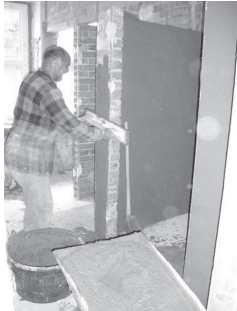
Prace wykonuje się wewnątrz obiektów...
