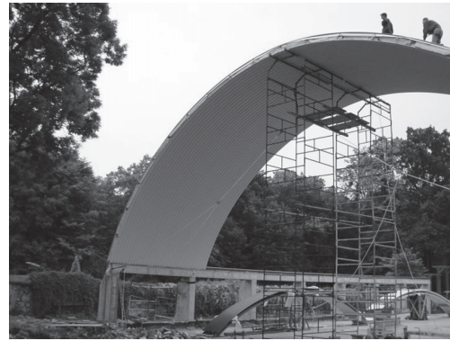
... jak i na zewnątrz, np. przy budowie zespołu boisk
